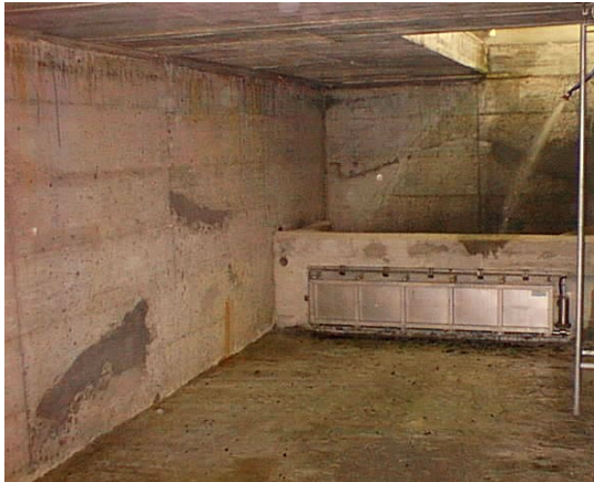
Figura 22 – Esempi di applicazione di vasche di laminazione sotterranee per piccole e medie estensioni, strutturabili sia per la sola laminazione con scarico in sistema di infiltrazione, sia per il riuso (tratte dal sito http://www.3ptechnik.it/it/home.html )
