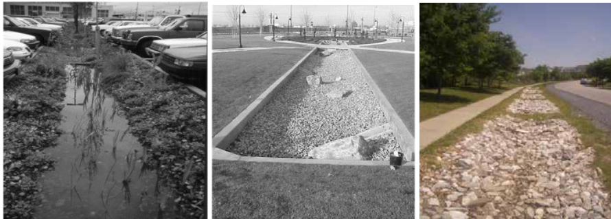
Figura 28 – Esempi di trincee d’infiltrazione
