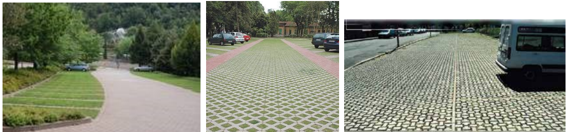
Figura 34 - Esempi di pavimentazioni permeabili
