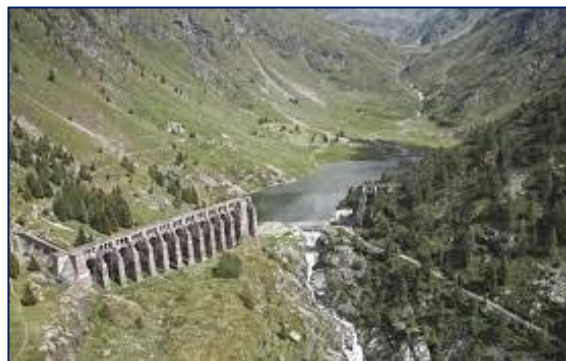
Collasso di una grande diga
