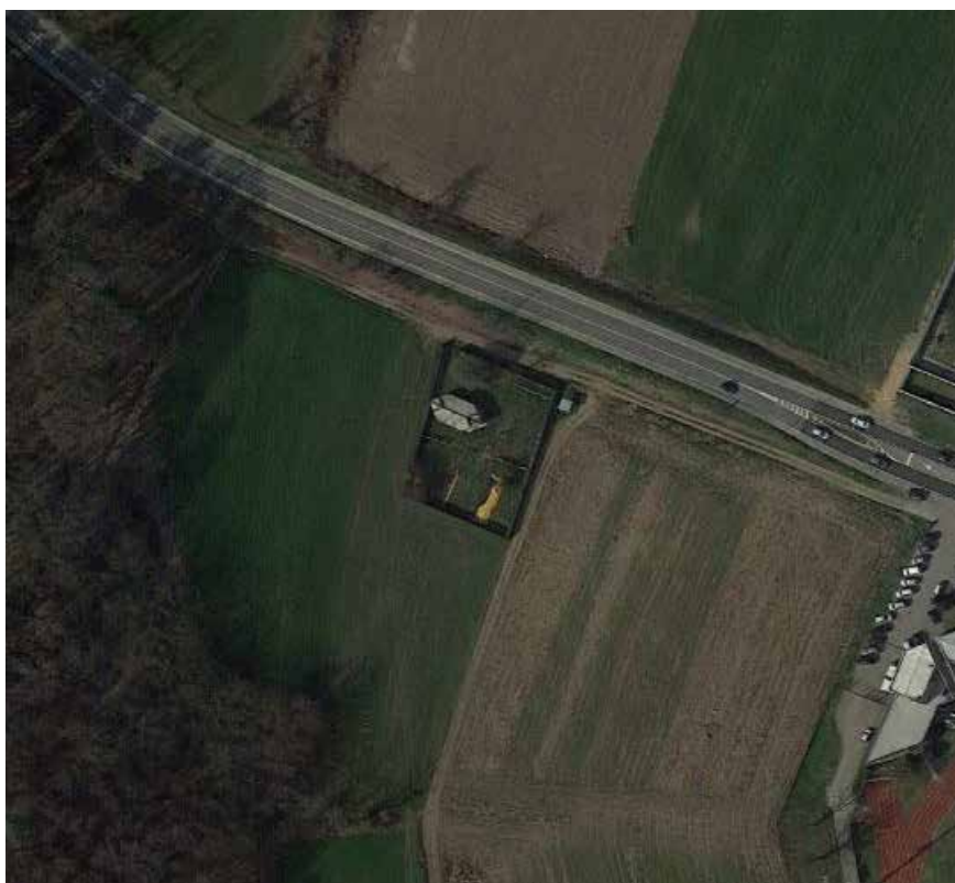
Impianti tecnologici a Guanzate
