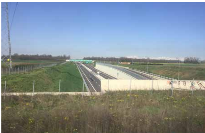
A fianco, Autostrada Pedemontana Lombarda
