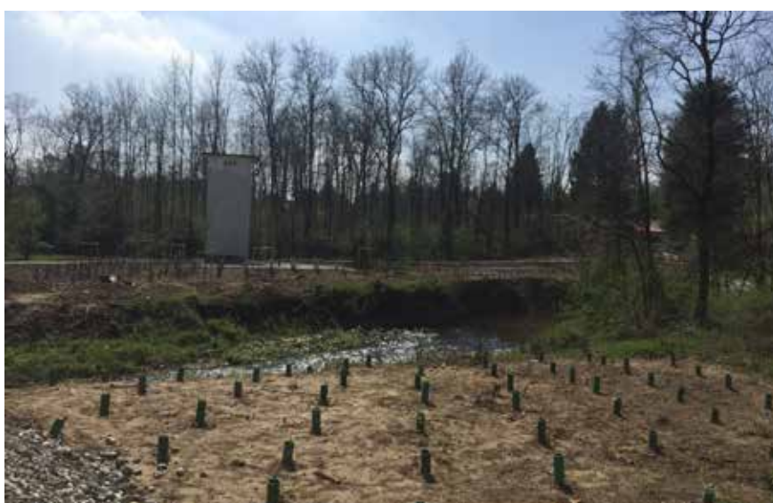
In alto. Cavalcavia di Autostrada Pedemontana Lombarda
